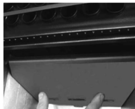
Fig. 14: levantar la placa cortafuego
